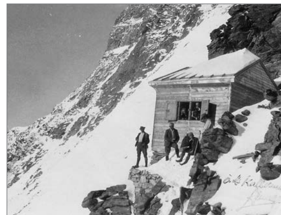
La refuge Solvay à la fin des travaux
